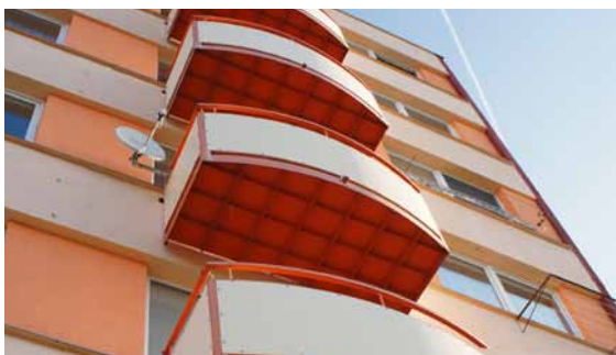
Nezakrytý pohled balkonu
